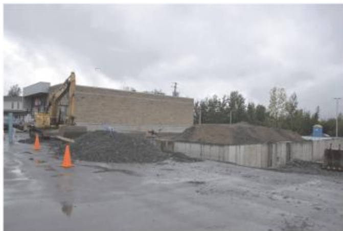
Les travaux sont déjà en cours.
