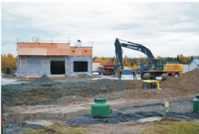
Photo des travaux au 16 octobre
